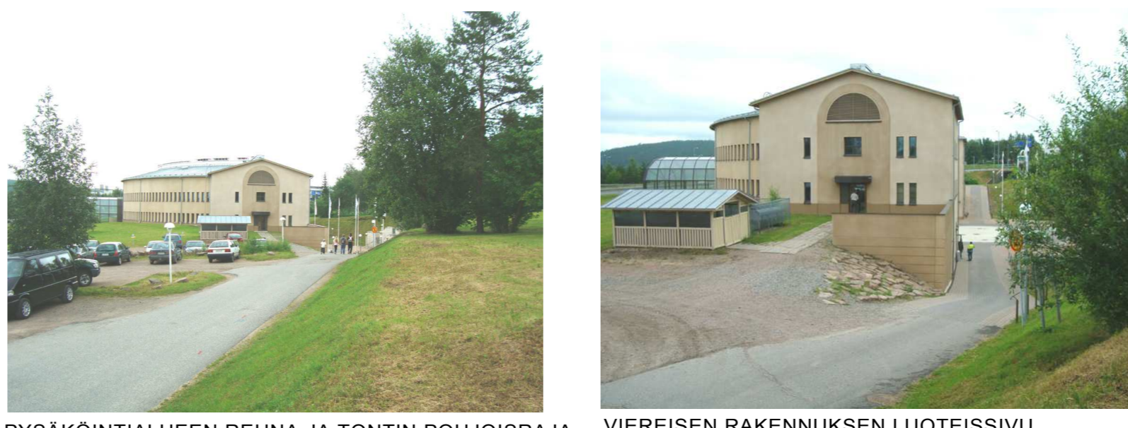
PYSÄKÖINTIALUEEN REUNA JA TONTIN POHJOISRAJA VIEREISEN RAKENNUKSEN LUOTEISSIVU
